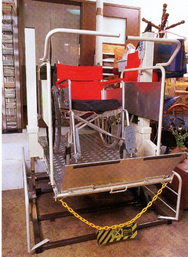
◀車いすのまま室内外へ移動できる段差解消機。設置できるのはスペースにゆとりがあればこそ
