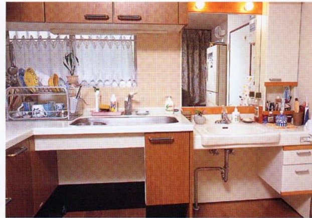
▲車いすに乗ったまま使えるキッチンと洗面所。 レバー式になっている水栓にも注目
